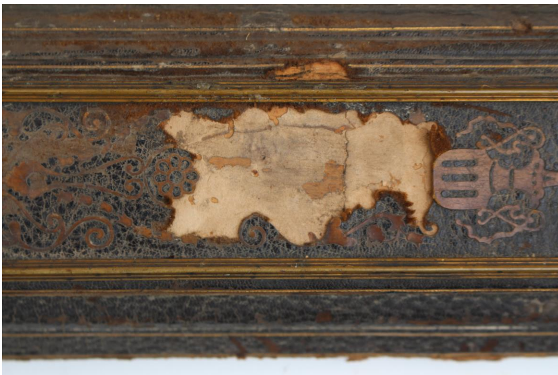
Detail poškodenia rámu
