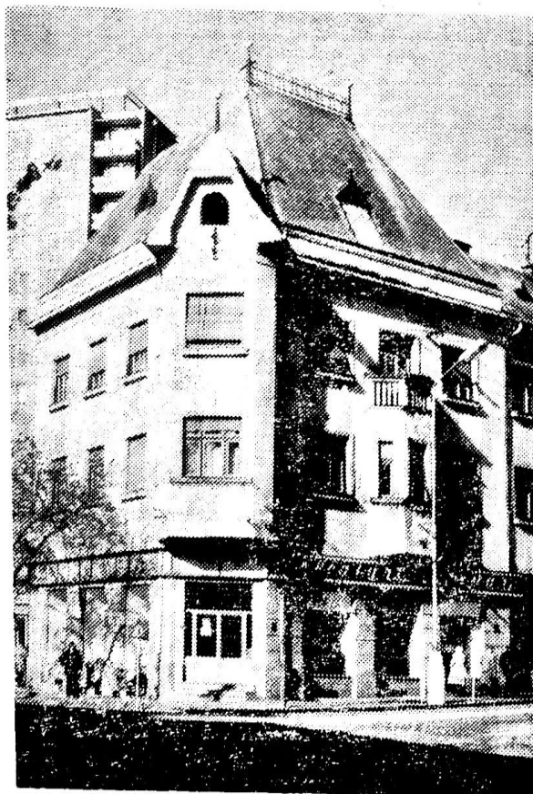
Terajšia budova Domácich potrieb — kovopredajňa, Námestie Hrdinov Roľnícka vzájomná pokladnica Levice 1931—1938, 1945—1948
